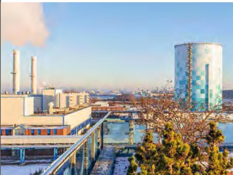
**PtH statt Erdgas:** Mit Elektrodenkesseln wie hier in Rostock wird erneuerbarer Strom, der sonst durch Abregelung verloren ginge, in klimafreundliche Wärme umgewandelt und in das örtliche Fernwärmenetz eingespeist. Der 45 Millionen Liter heißes Wasser fassende Großspeicher ging 2023 in Betrieb.
